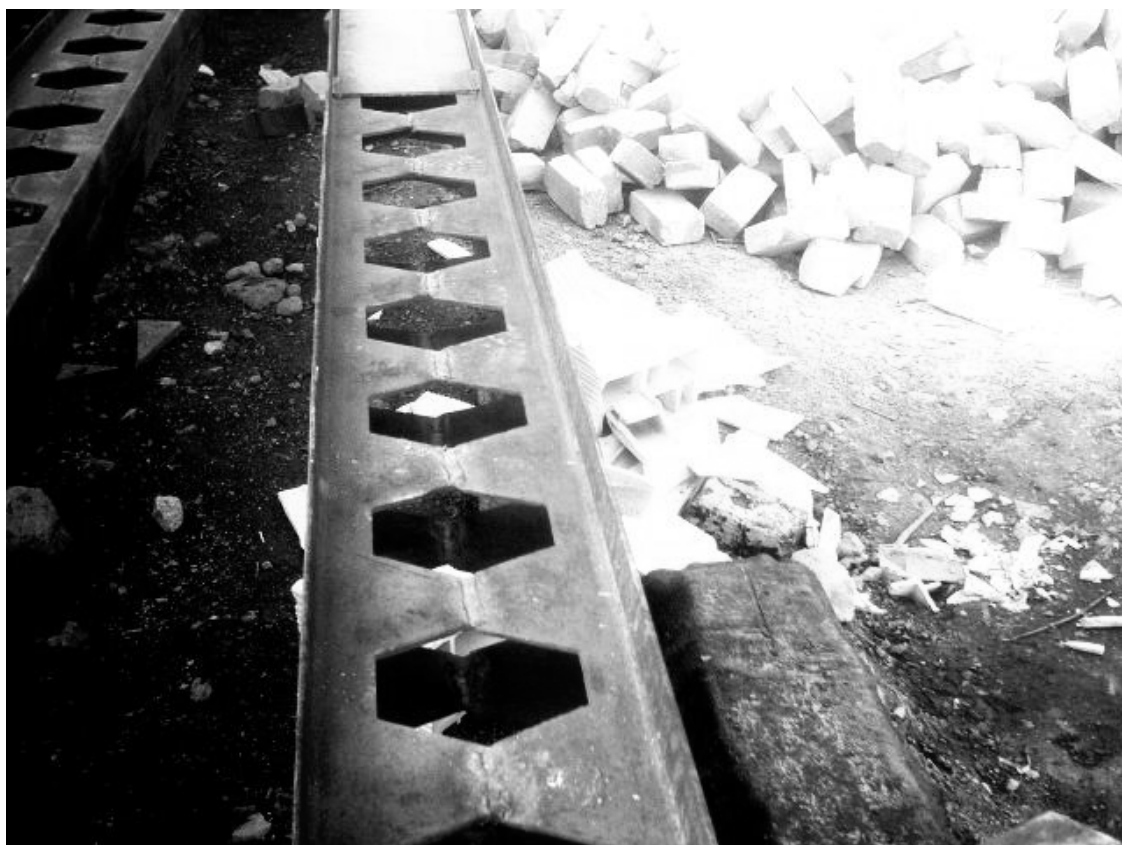
شکل مقطع تیر لانه زنبوری
