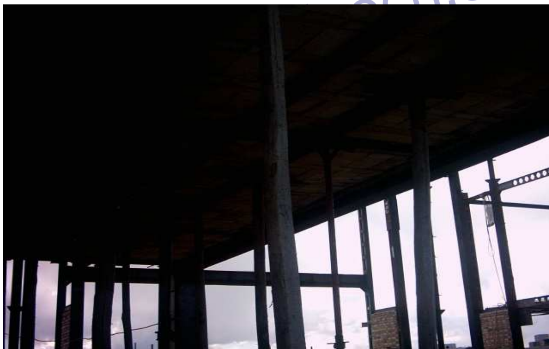
شمع بندی زیر سقف قبل از بتن ریزی
