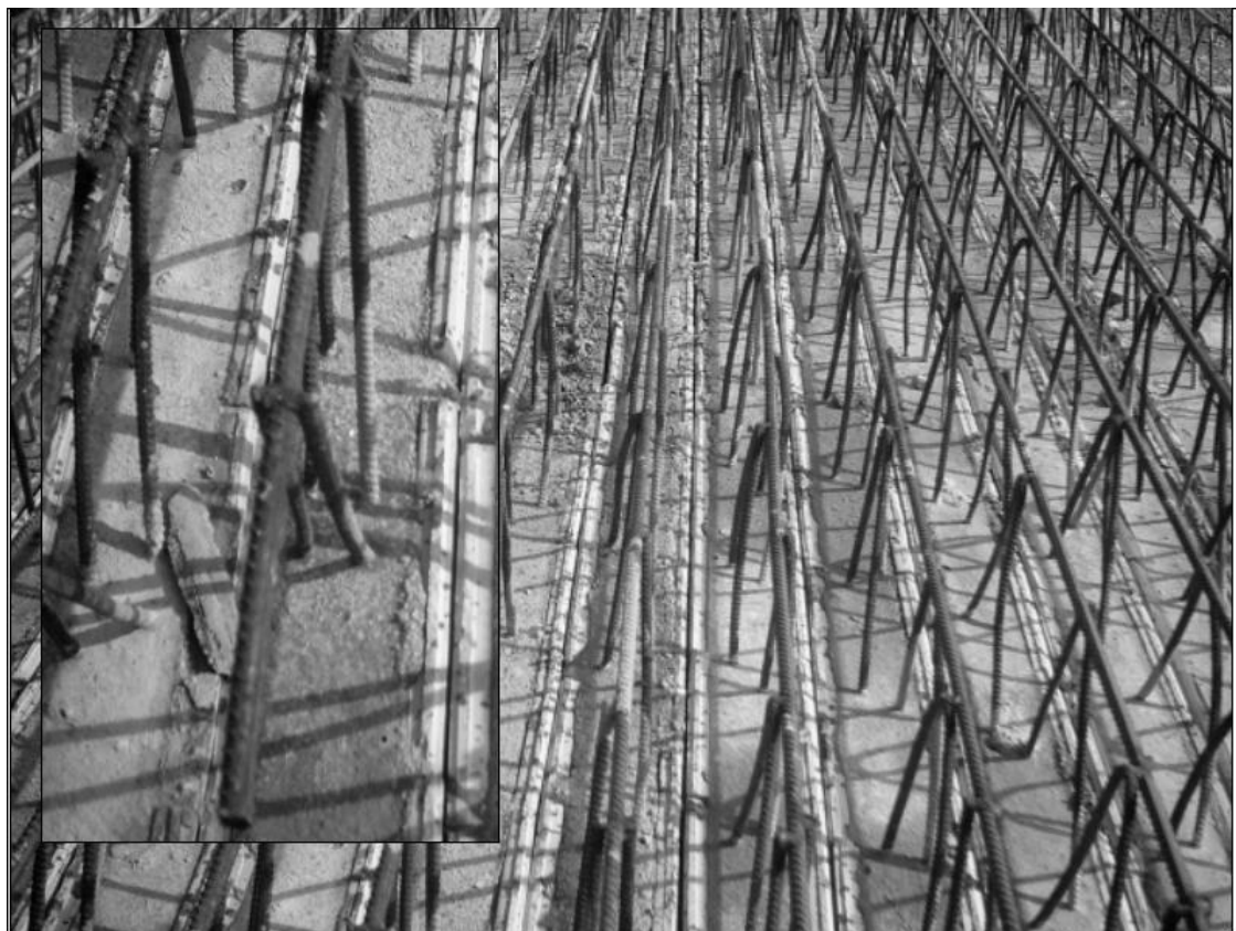
اجزای مختلف تشکیل دهنده تیرچه ها
