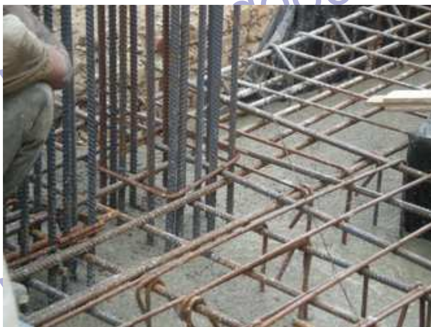
بتن ریزی فونداسیون
