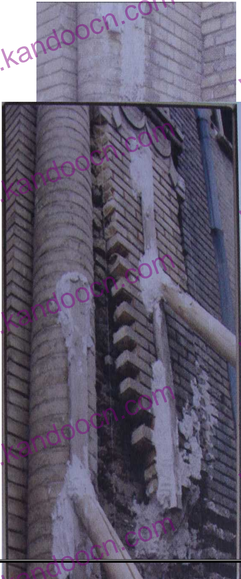
شروع به چیدن یکی از ستون های مدور با آجر تراش خورده سردر شهرداری کرمانشاه
