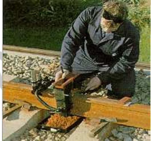
شکل ۱۰: آب بندی درزها جهت جلوگیری از ریزش مذاب شکل ۱۱: مشعل پیشگرم مخصوص
