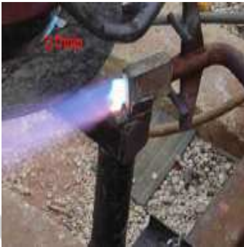
شکل ۱۰: آب بندی درزها جهت جلوگیری از ریزش مذاب شکل ۱۱: مشعل پیشگرم مخصوص
