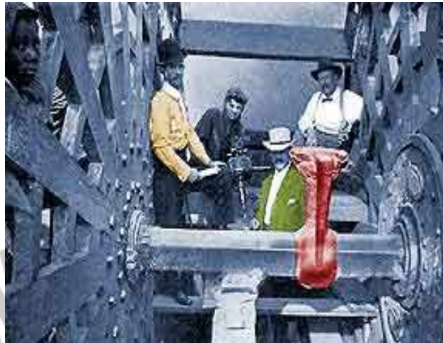
شکل ۱۶: انجام تعمیرات اساسی بوسیله جوش ترمیت
